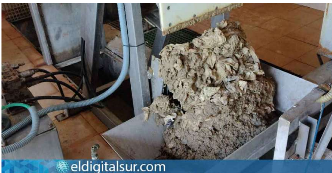
Parte del equipo de Aqualia retirando residuos de las redes de saneamiento de Güímar / EDS
